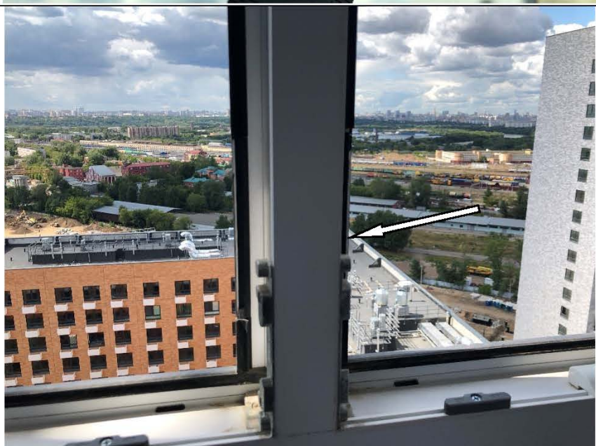
Фото №20. Частично отсутствуют уплотнительная резинка оконного блока ПВХ.
