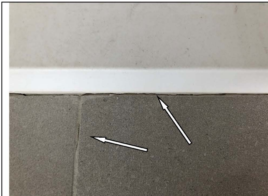
Фото №28. Дефект шва напольной плитки в коридоре.
