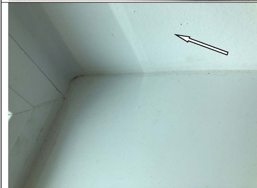
Фото №17. Дефект на откосе оконного блока в спальне.
