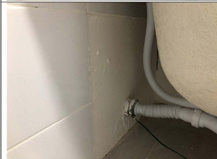
Фото №32. Отсутствует часть настенной плитки за ванной.
