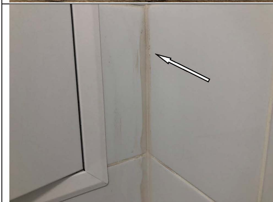
Фото №30. Загрязнение настенной плитки раствором в ванной комнате.
