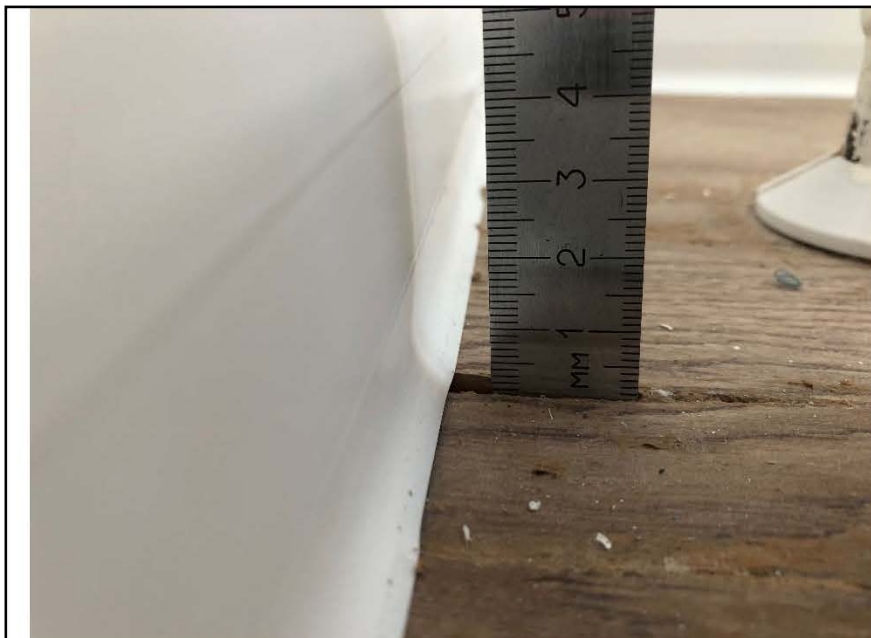
Фото №22. Зазор между паркетными досками в кухне.
