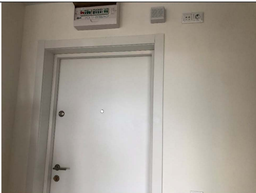
Фото №1. Общий вид коридора в квартире.
