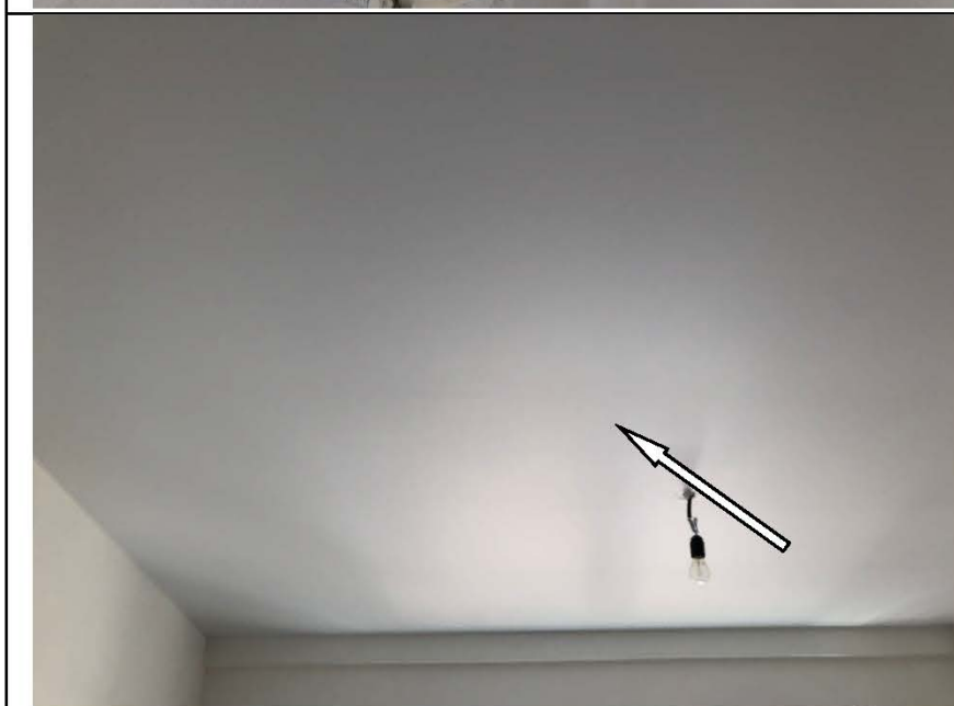
Фото №24. Загрязнение натяжного потолка в кухне.
