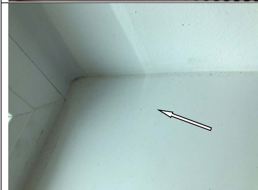
Фото №15. Загрязнения на подоконной доске оконного блока в спальне.
