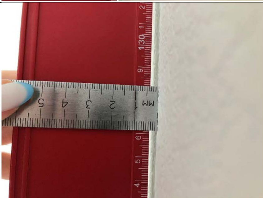
Фото №6. Измерение уровня стен коридора в квартире.
