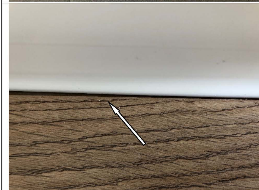
Фото №29. Щель в напольном покрытии в спальне.
