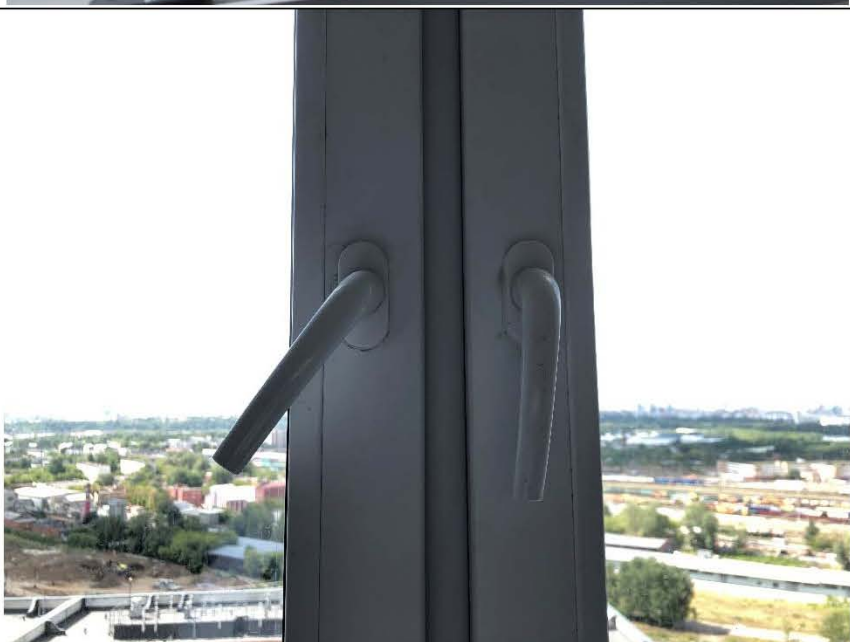
Фото №21. Фурнитура оконного блока ПВХ в спальне не отрегулирована.
