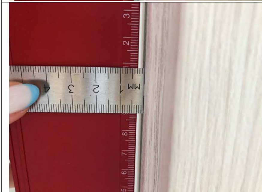
Фото №9. Измерение наличника дверного блока спальни в квартире.
