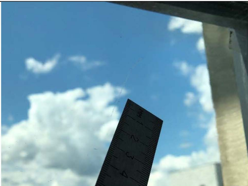
Фото №19. Царапина на стеклопакете оконного блока ПВХ в спальне.
